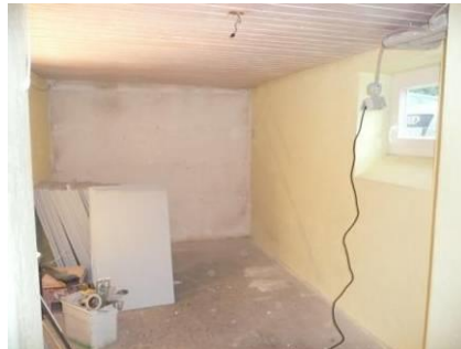
Schimmelbehandlung mit AS Fluid im Kellerraum
